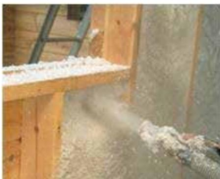
Влажное наполнение стен эковатой
