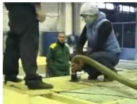
Установка для сухого наполнения стен эковатой на «УралСтройХолдинг»
